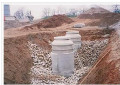
FIG. 17: FOTO DI RIFERIMENTO MESSA IN OPERA DEL POZZO DISPERDENTE
